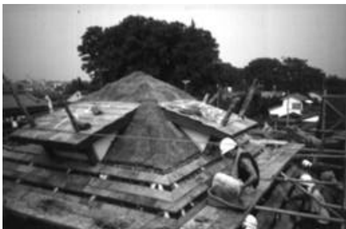
⑨ タンポポ・ハウス 屋根の施工風景
